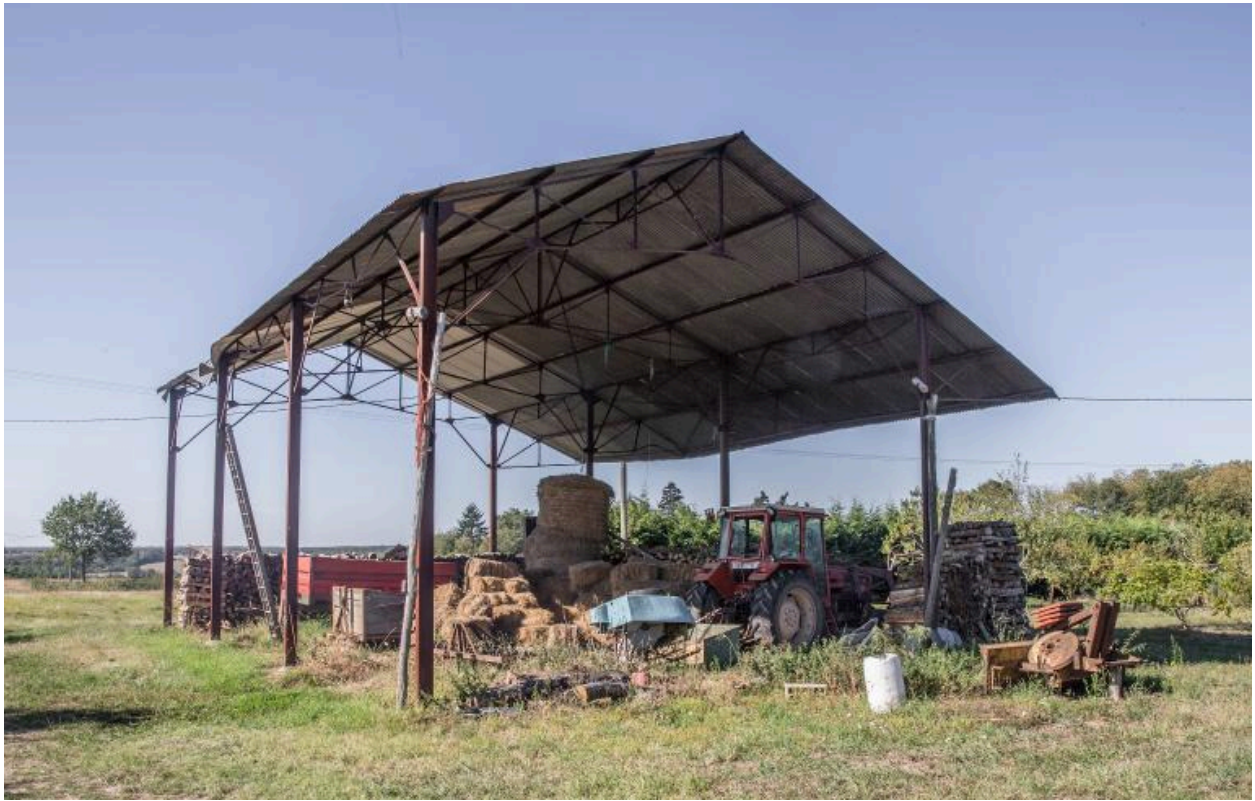
Hangar agricole à structures métalliques.
