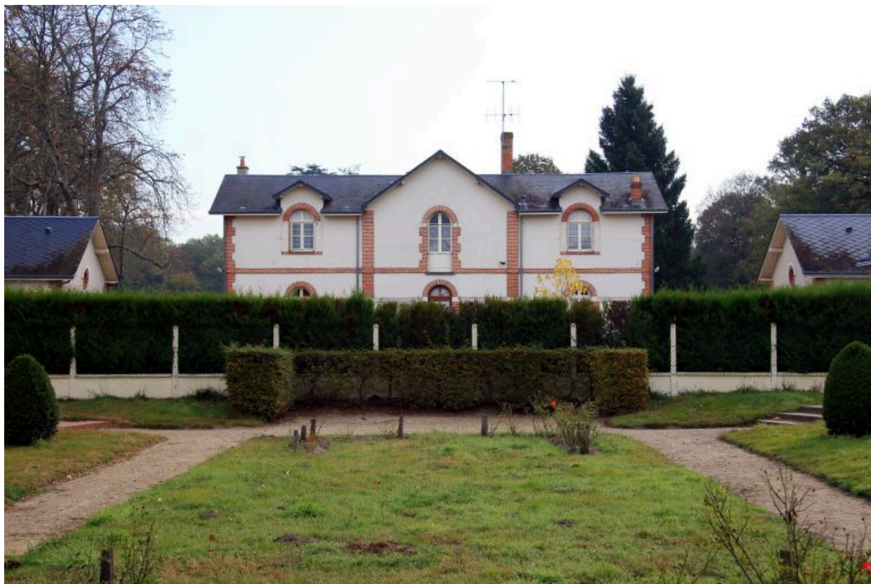
Les communs, logement principal : façade sur la cour.
