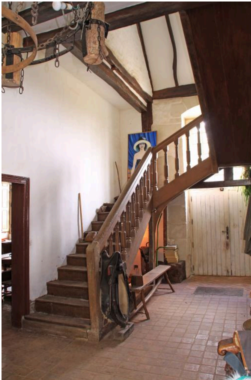
Vestibule, escalier à balustres passant devant la porte de la façade postérieure.
