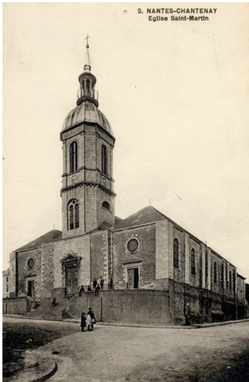
Eglise Saint-Martin, vue de la rue Eugène Roux, début du XXe siècle.
