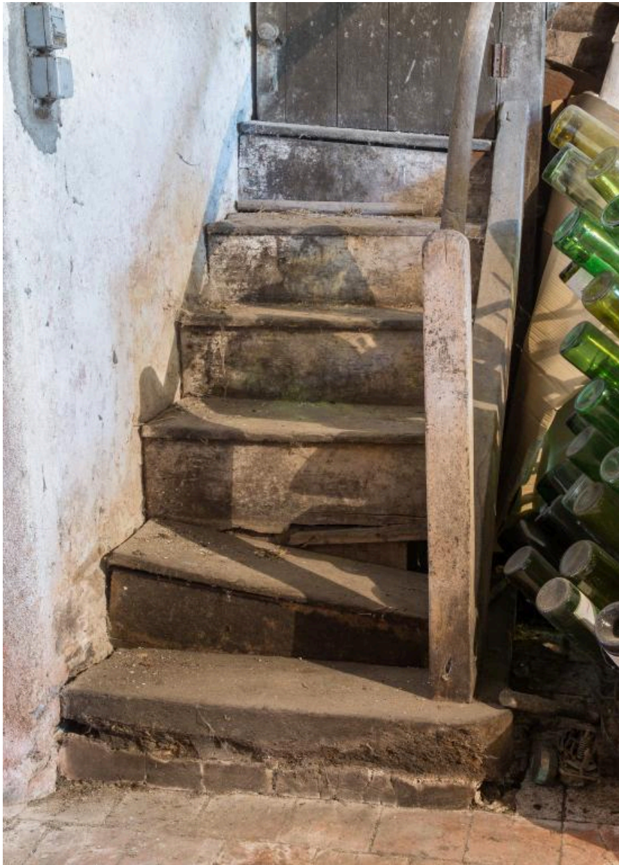
Escalier d'habitation en charpente tournant avec contremarche (détail). Cadastre 2018, B 01-710.
