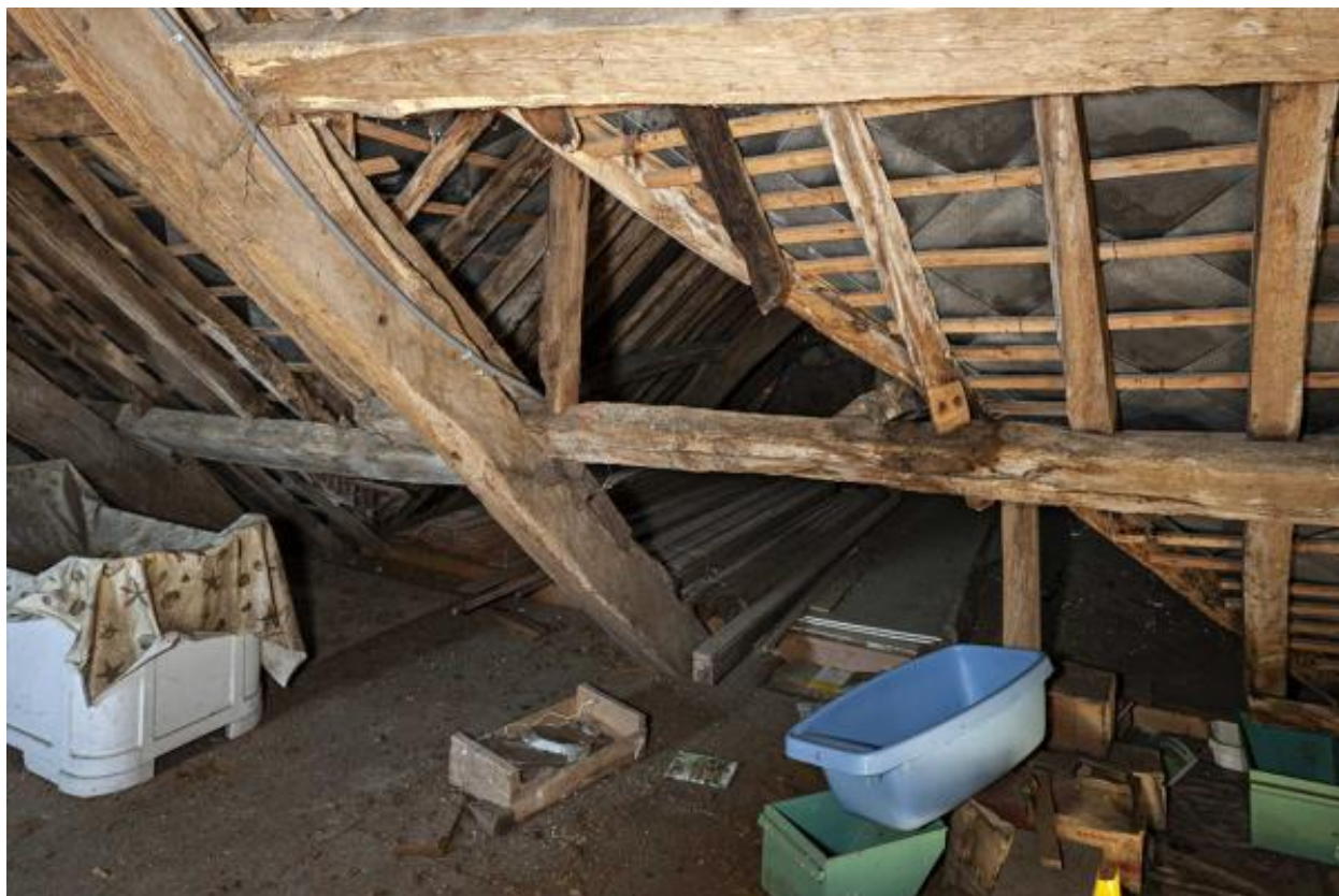
Logis sud, charpente.
