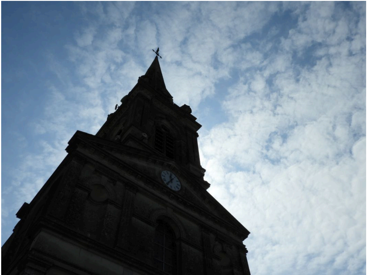
Le clocher vu depuis l'ouest.
