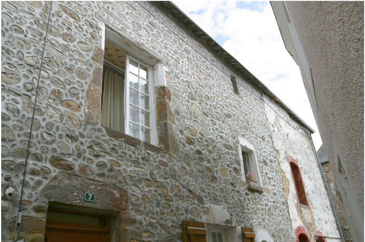
Détail de l'élévation ouest : les ouvertures du premier étage.
