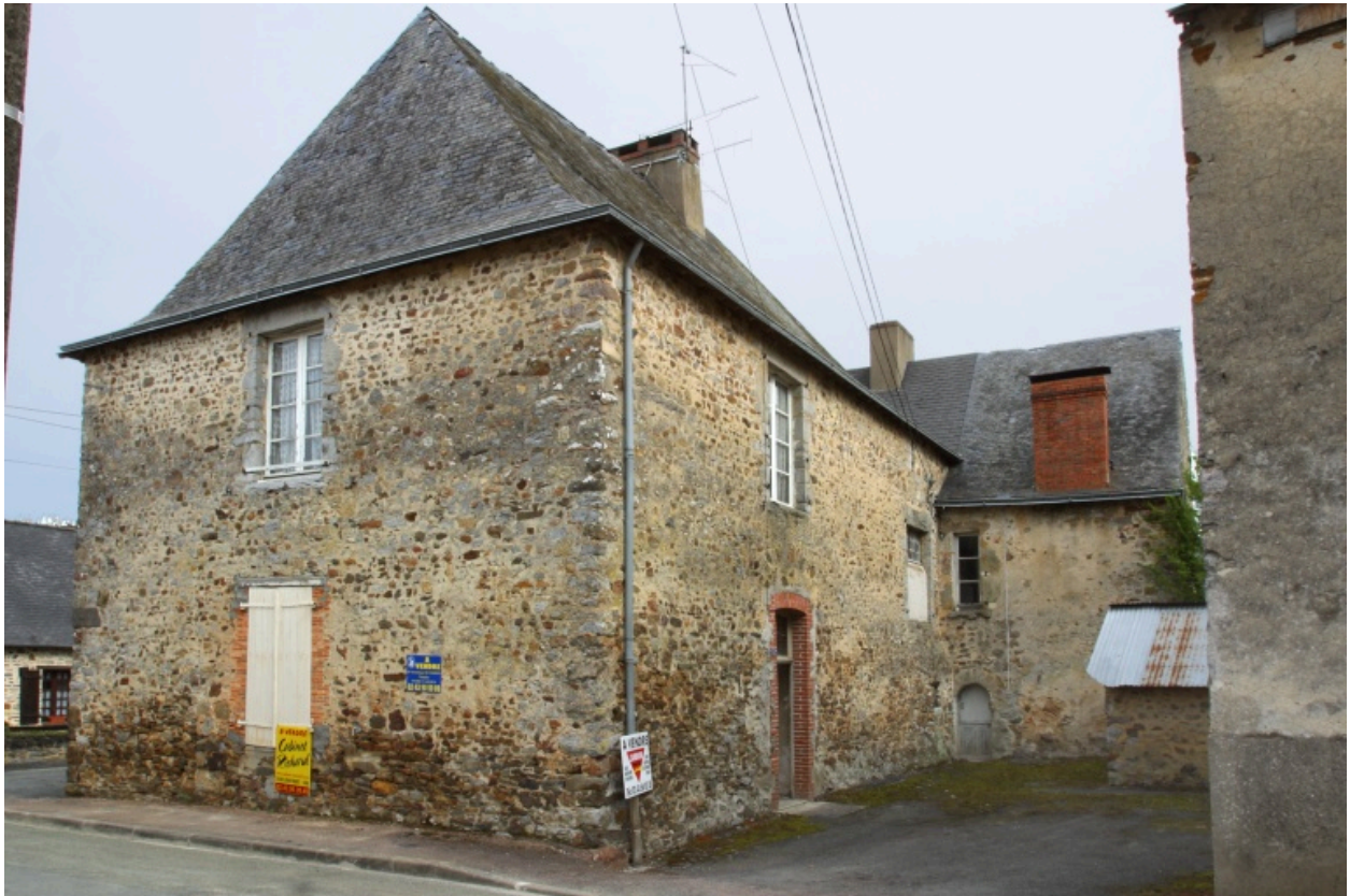
La maison vue depuis la rue du canal au sud-est.
