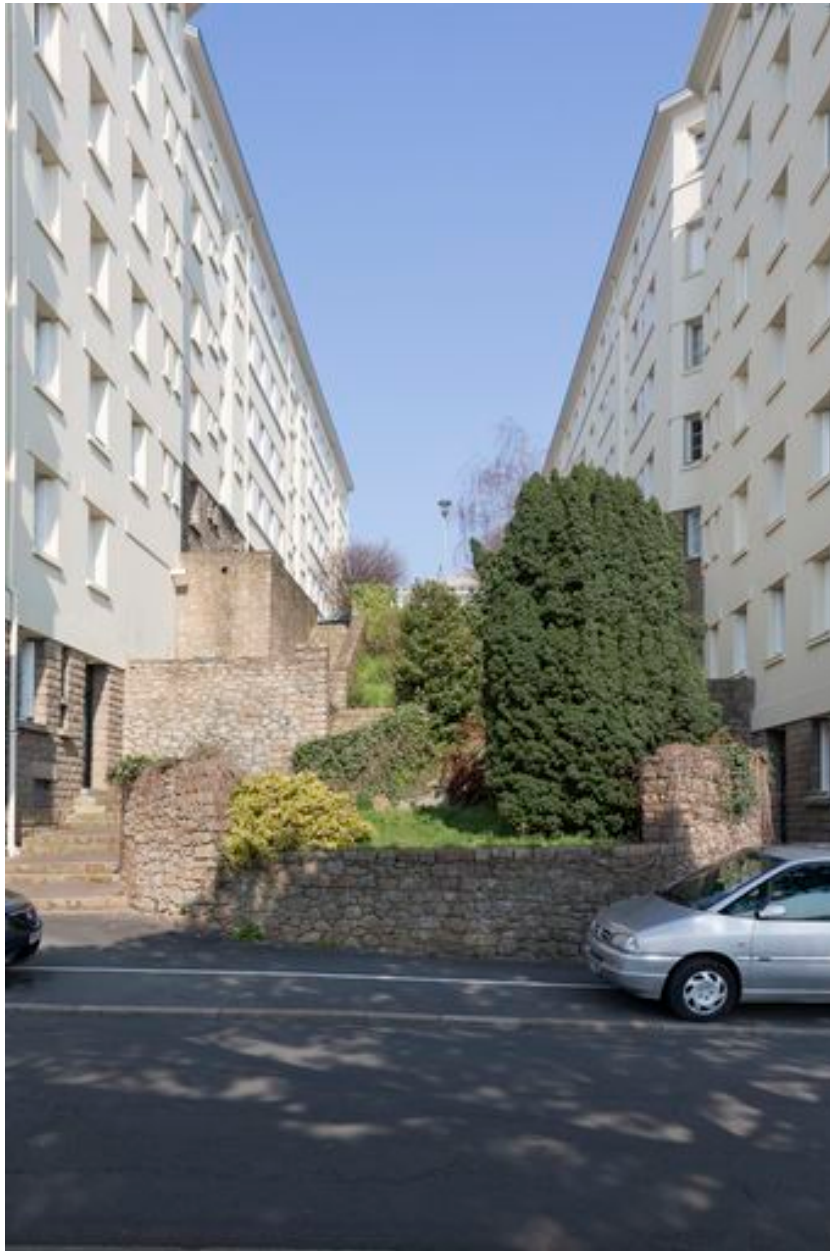
Escalier situé entre les bâtiments B et C.
