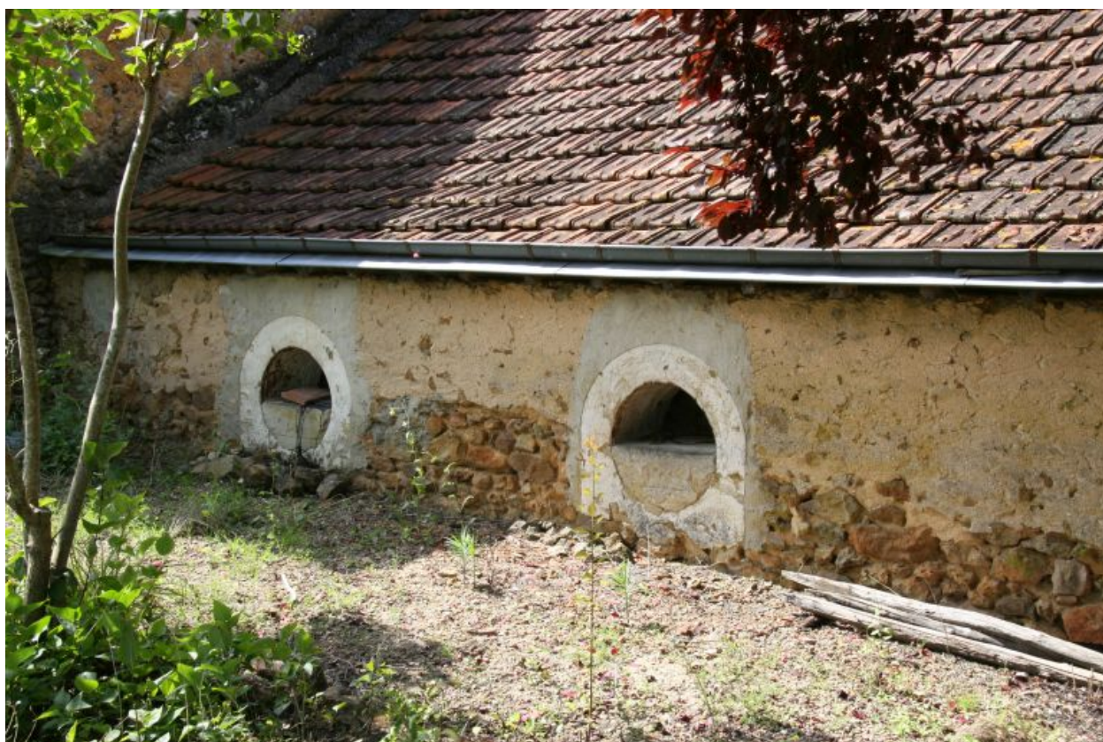
Les communs, corps central : façade postérieure.
