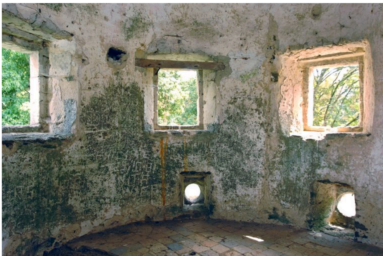
Étage de l'échaugette : baies.
