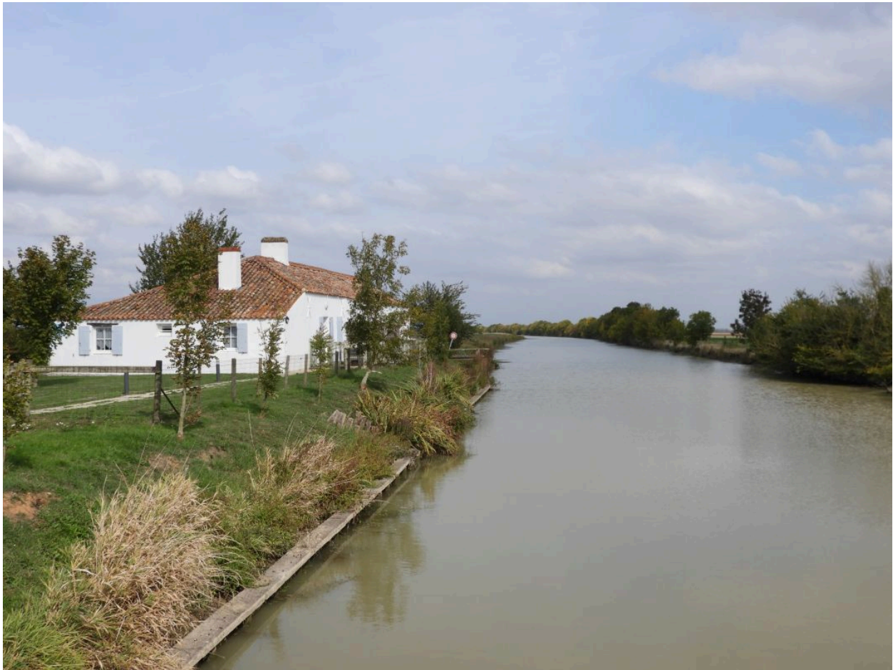
L'ancienne maison de garde, sur la rive droite du canal, vue depuis le sud.
