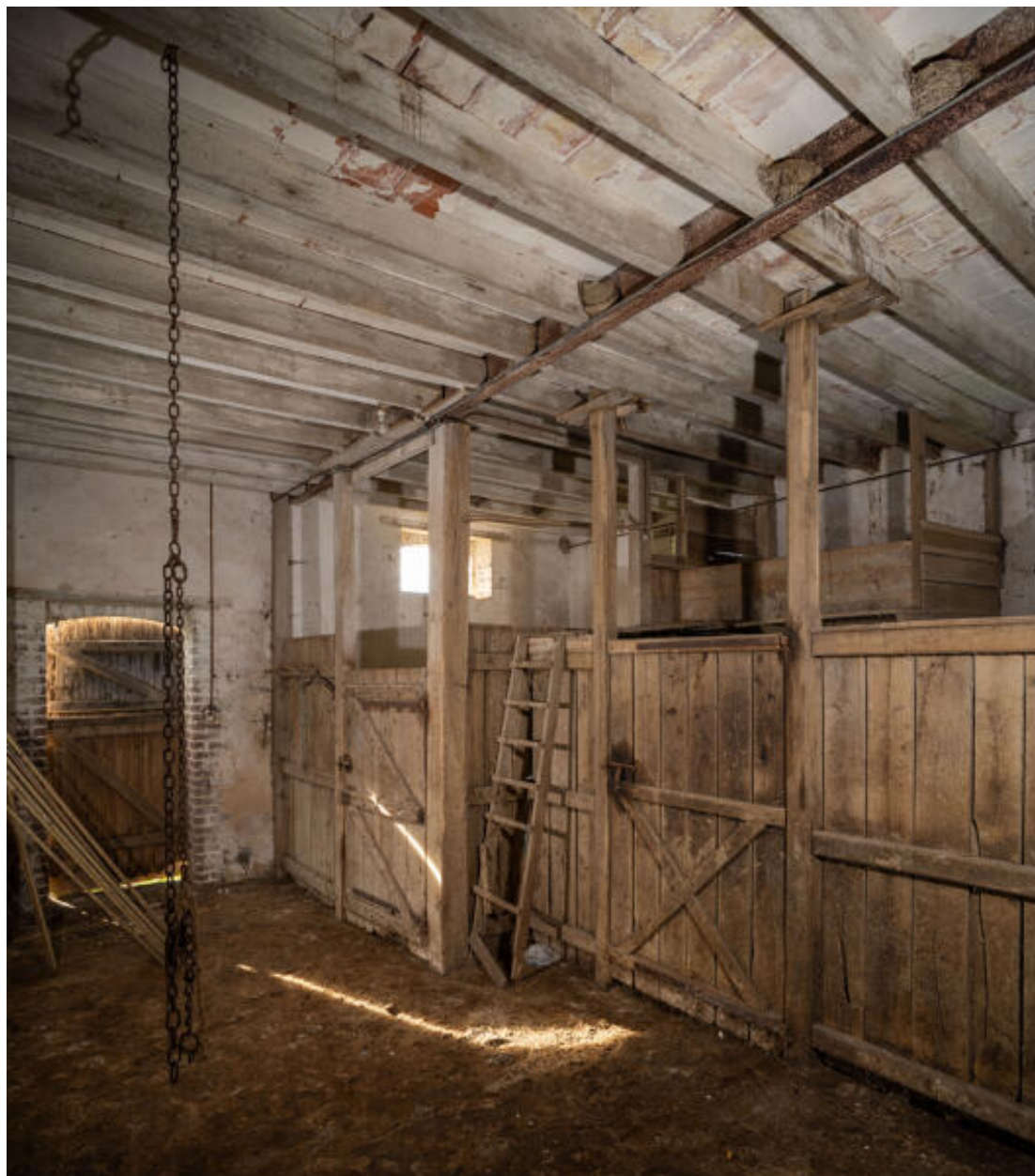
Écurie : intérieur avec stalles en bois.
