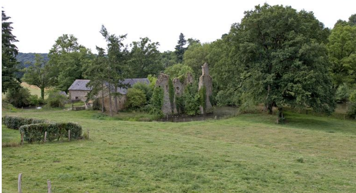
La motte et la maison-forte : vue d'ensemble depuis le nord.
