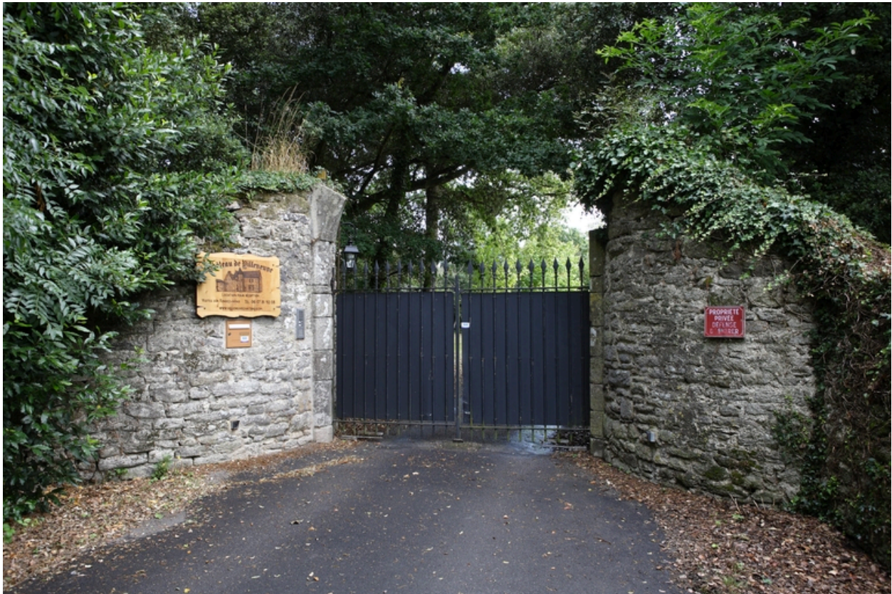
Mur de clôture. Vue du portail d'entrée.
