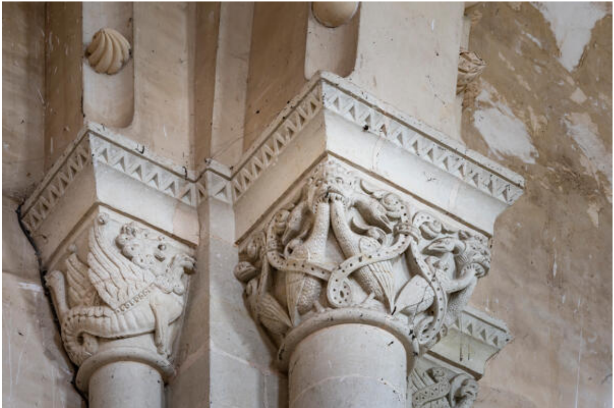
Chapiteaux sculptés des colonnettes séparant la troisième de la quatrième travée, côté sud.
