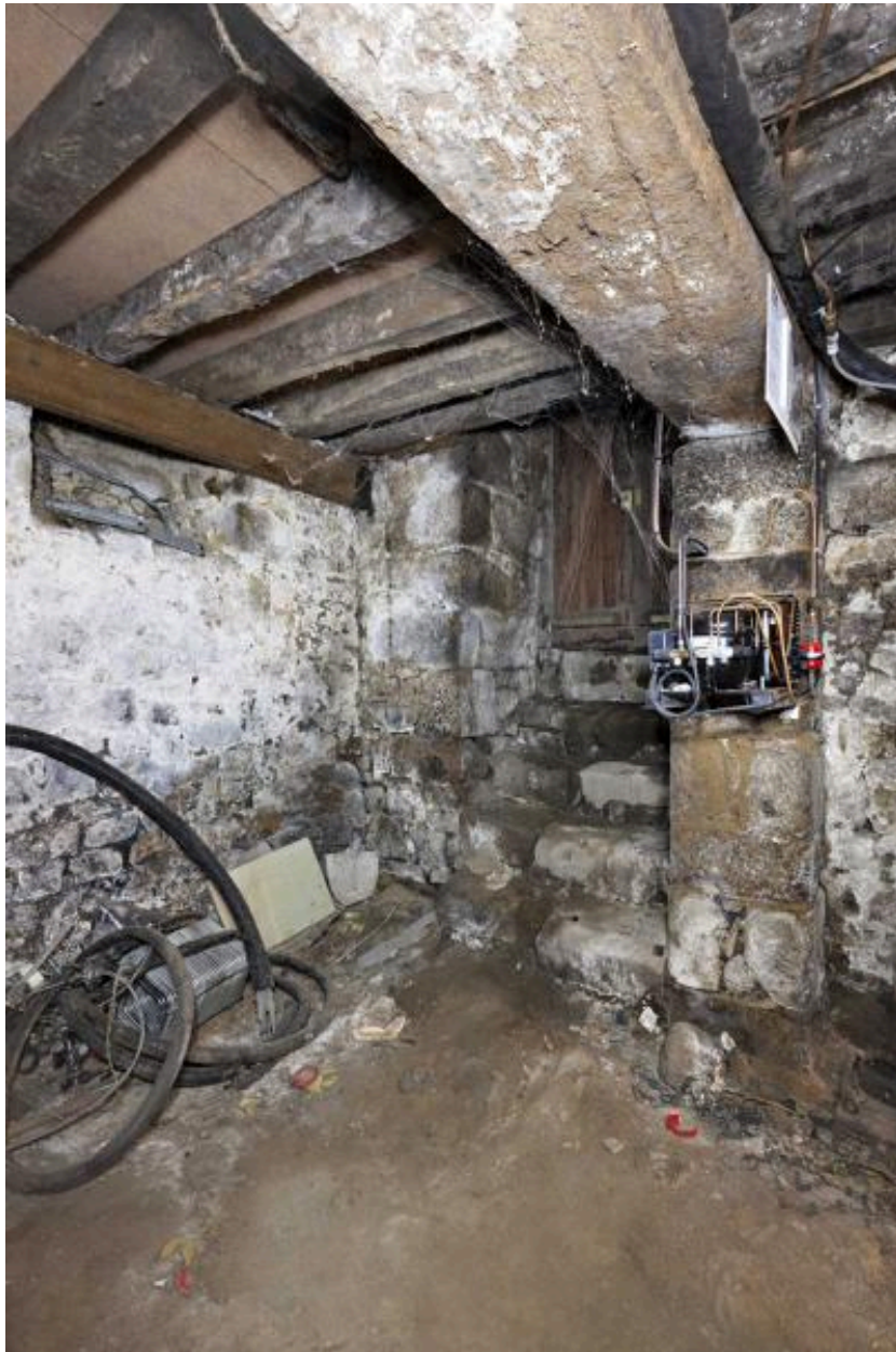
2-4 place du 8-Mai-1945, cave située sous la partie sud de l'ensemble.
