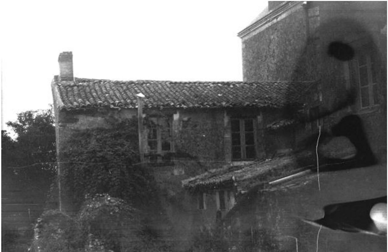
Ancien logis accolé à l'hospice Notre-Dame des Anges, vue depuis l'ouest.
