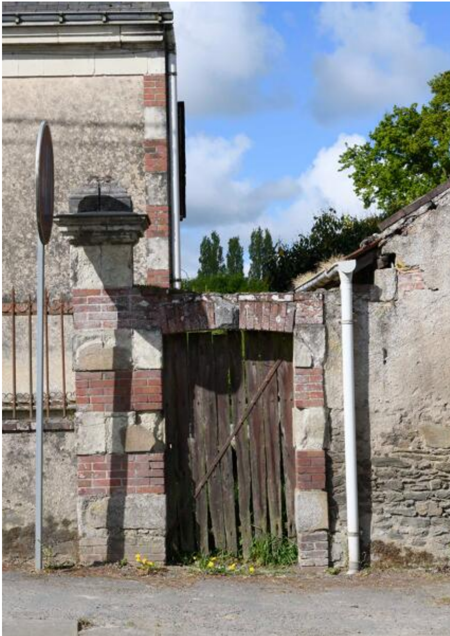
Détail de la porte piétonne latérale.
