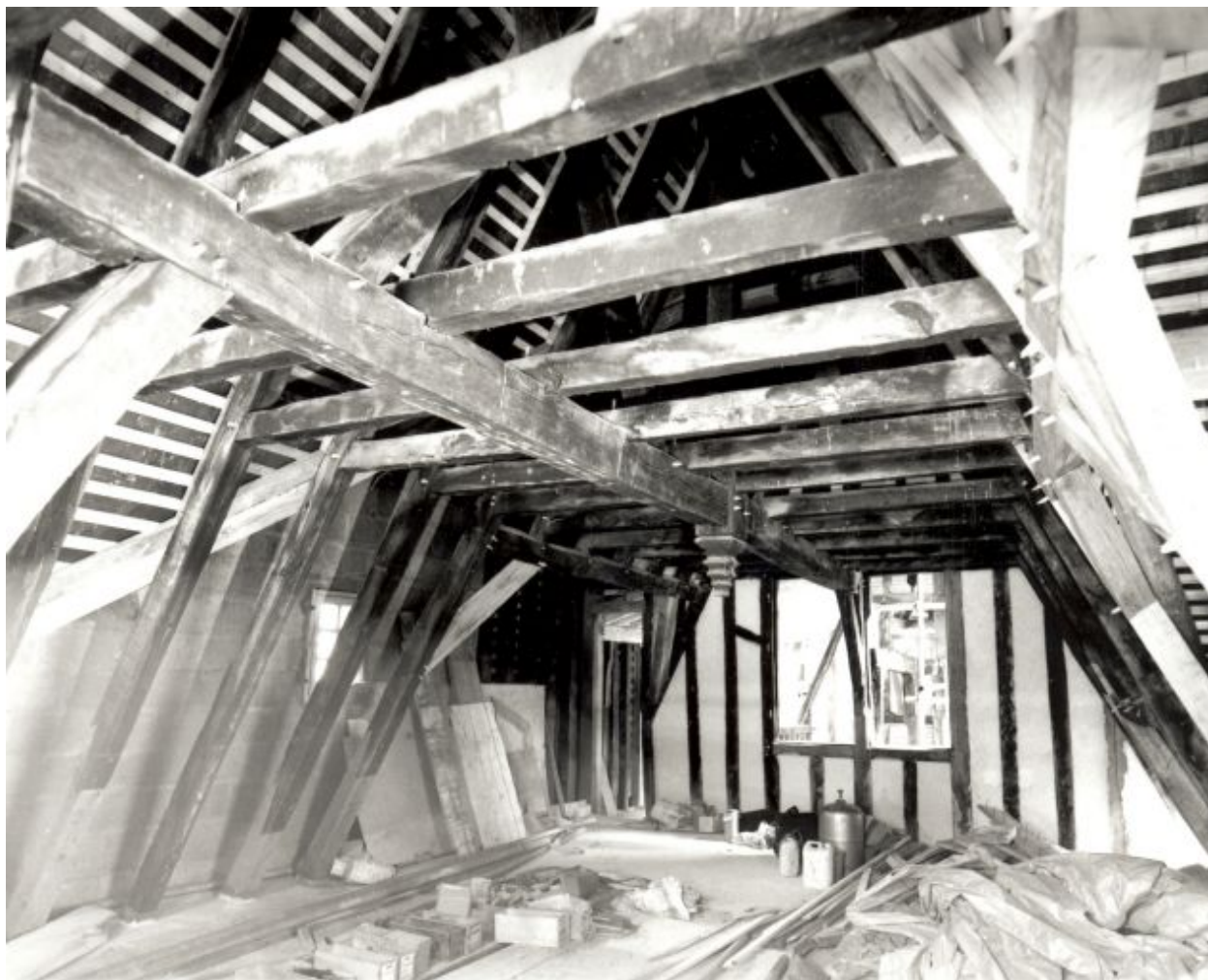
Corps postérieur, la charpente : vue longitudinale depuis l'angle postérieur gauche. Etat pendant les travaux de restauration.
