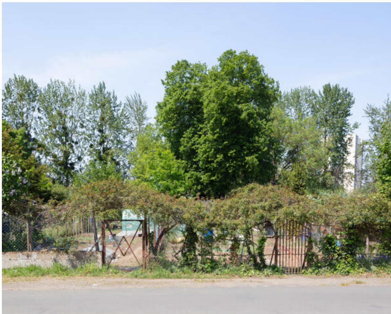
Vue des clotures de jardins dits ouvriers composées de grillage et de poteaux fasciculés béton.
