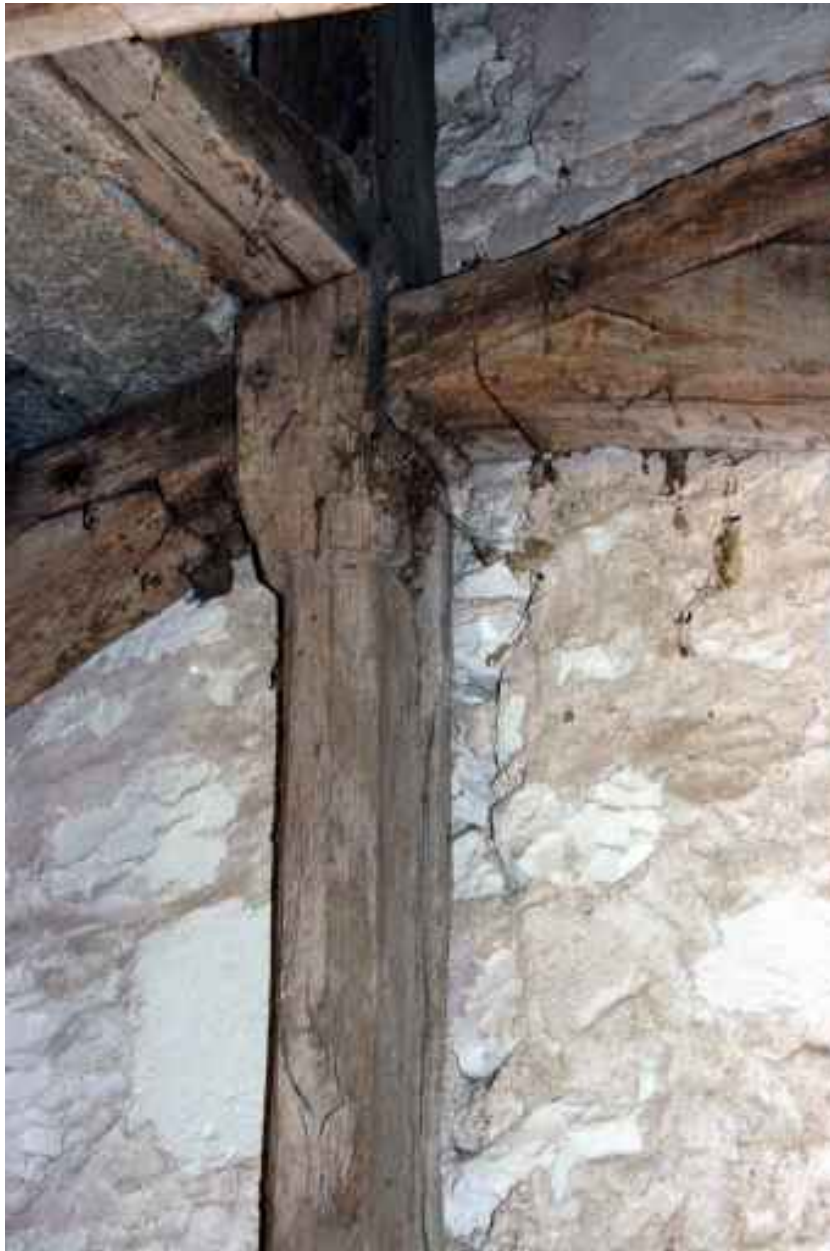
Le logis, charpente : assemblage.
