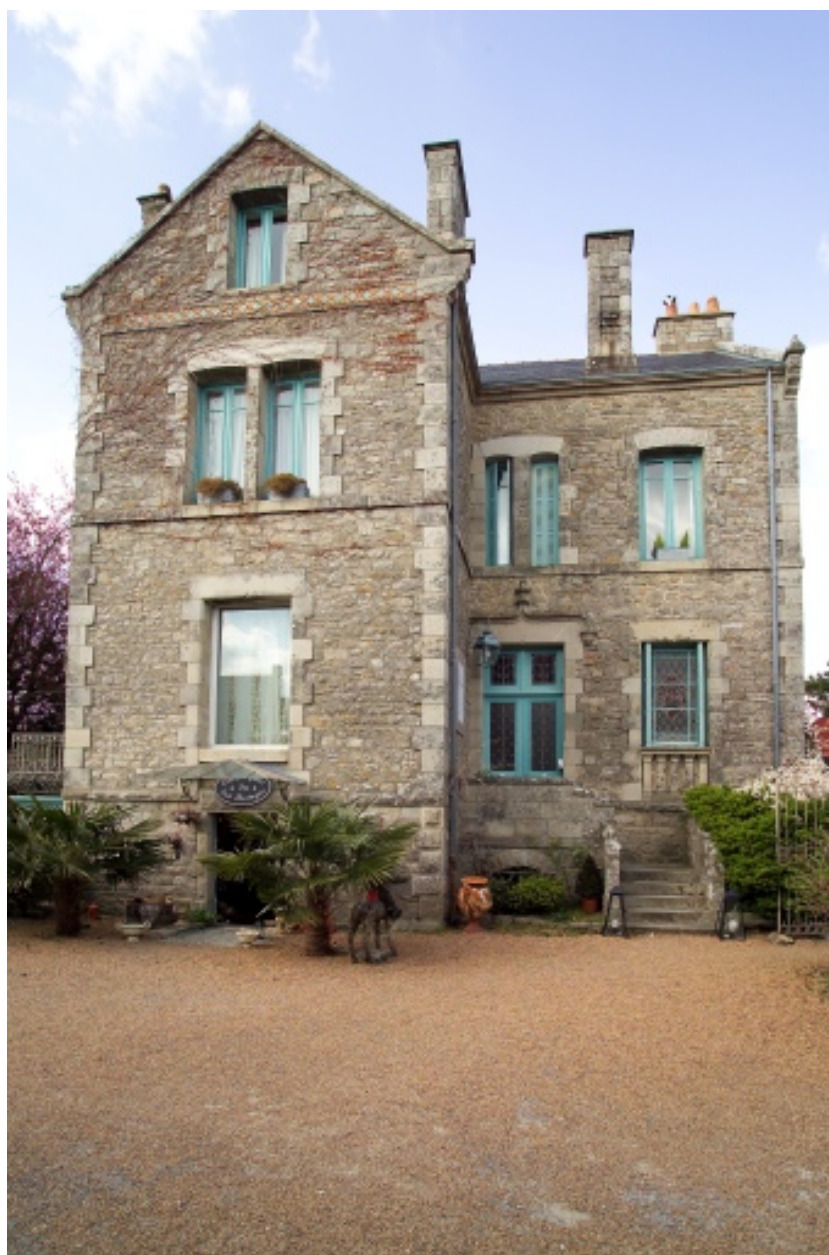
Façade vue vers le Nord.
