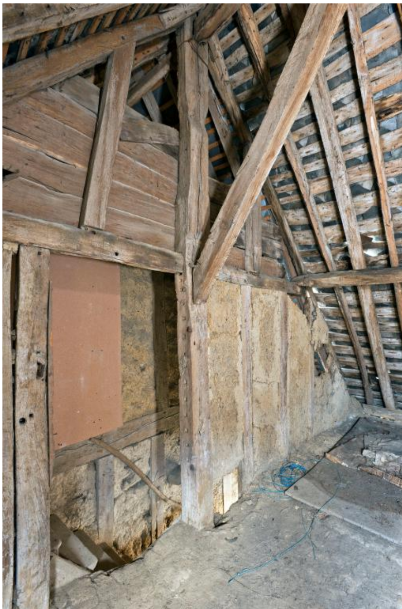
Maison 2, comble, pignon ouest : détail.
