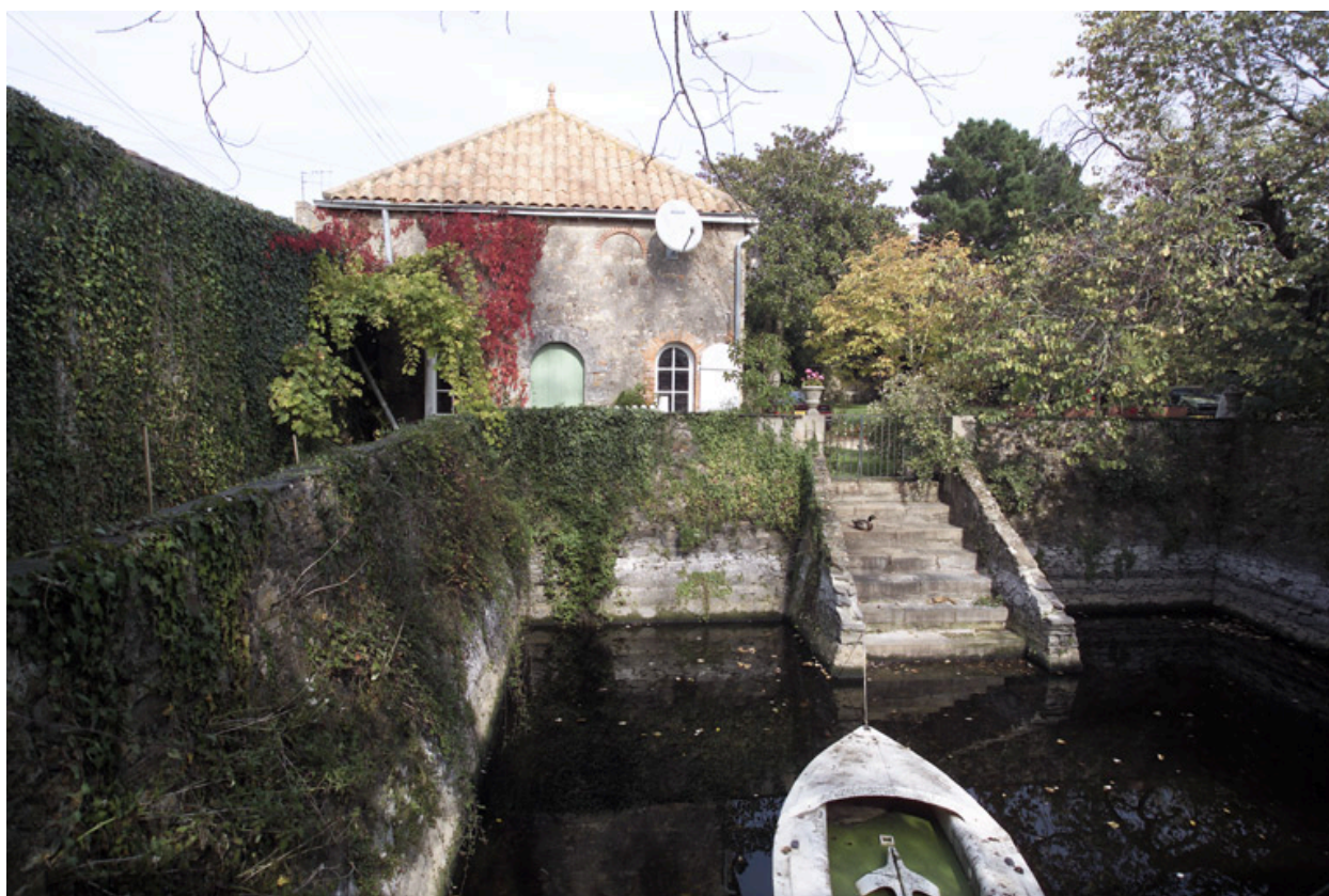
Vue du pignon de la dépendance depuis le vivier situé à l'angle sud-ouest.
