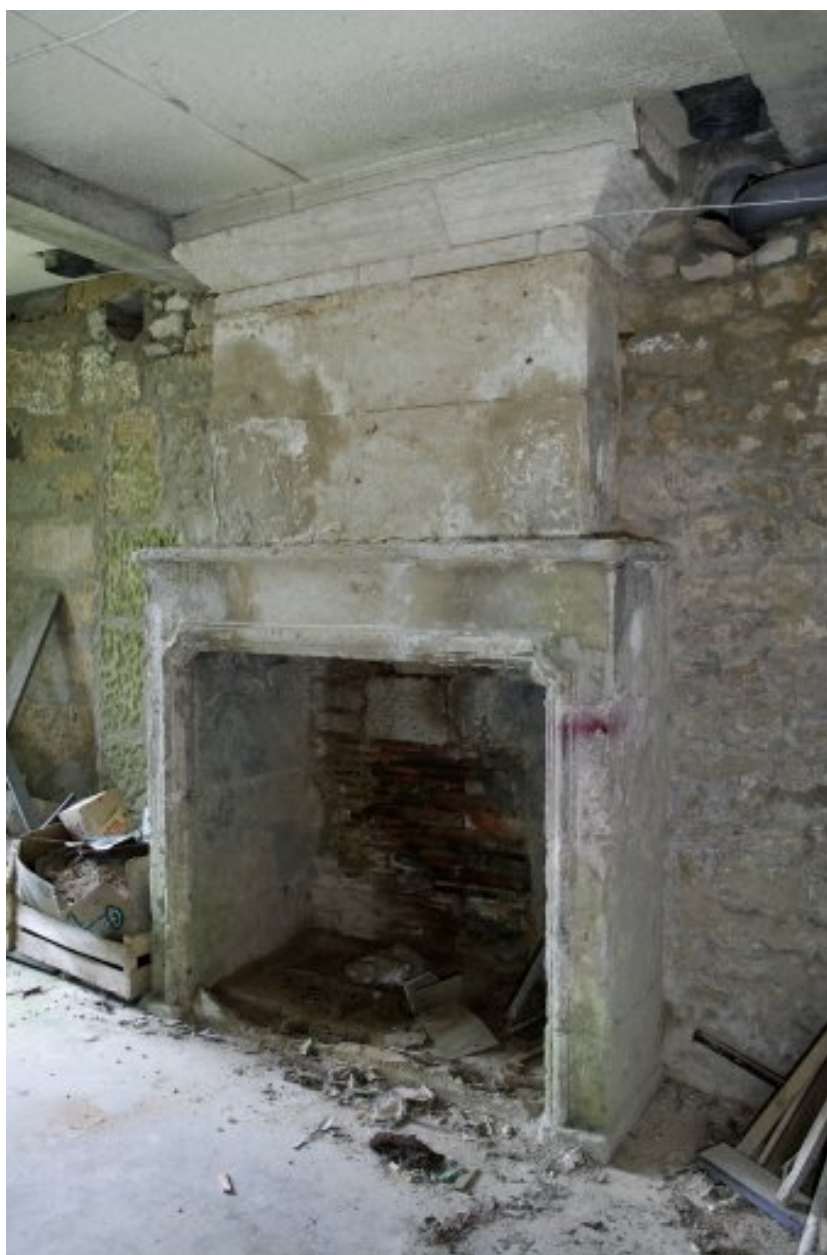
Cheminée au rez-de-chaussée du bâtiment sud.
