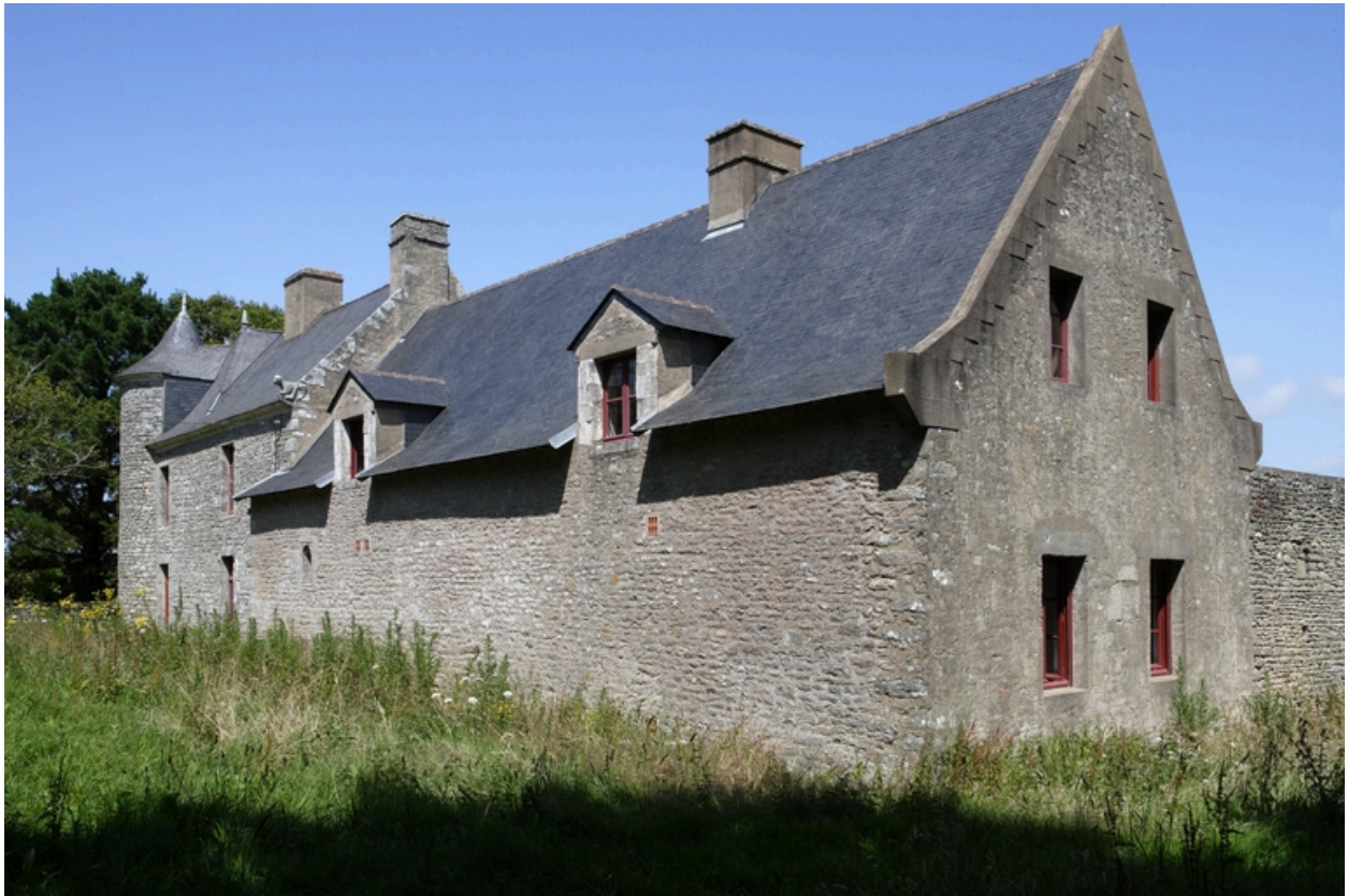
Façade ouest. Vue depuis le sud-ouest.
