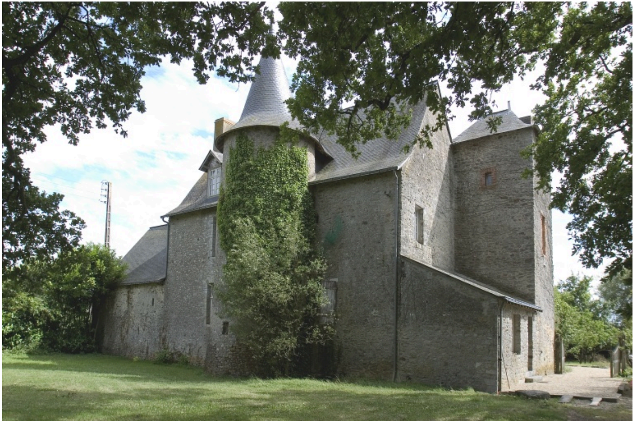
La façade postérieure et le pignon ouest.
