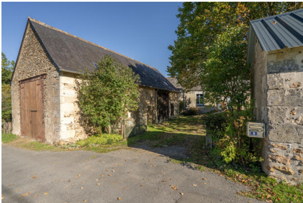
Ferme ouest : entrée de la cour.
