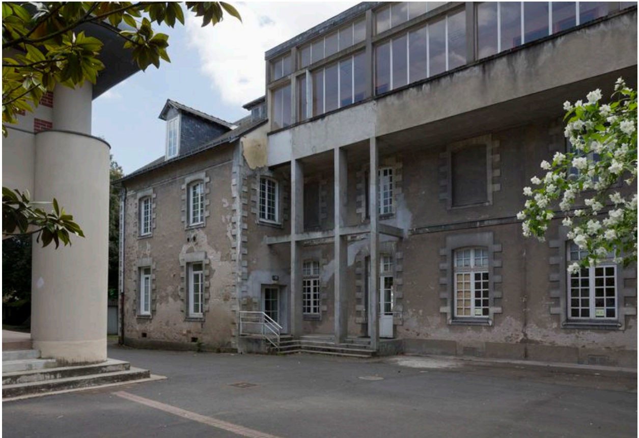
Façade arrière nord modifiée lors de l'aménagement d'une galerie en béton dans les années 1980.
