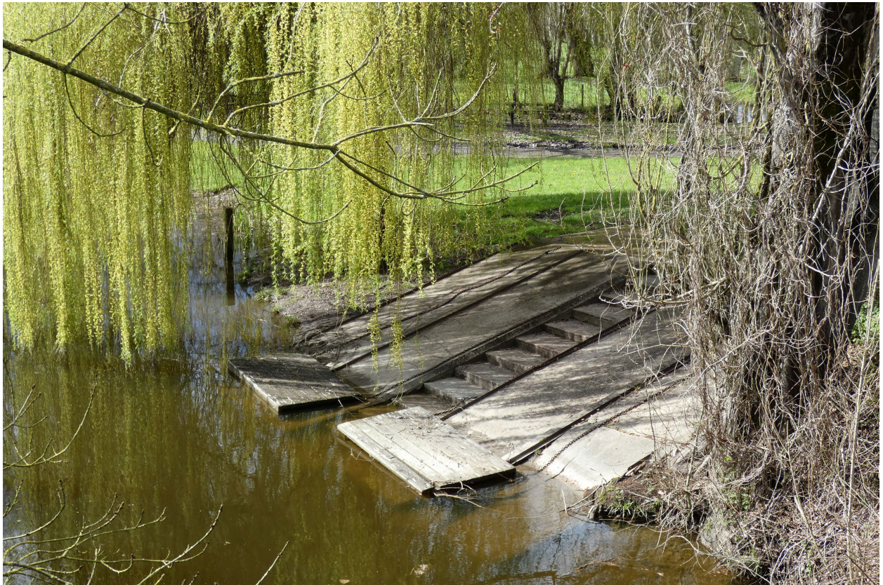
Le lavoir mobile en aval du pont vu depuis l'est.
