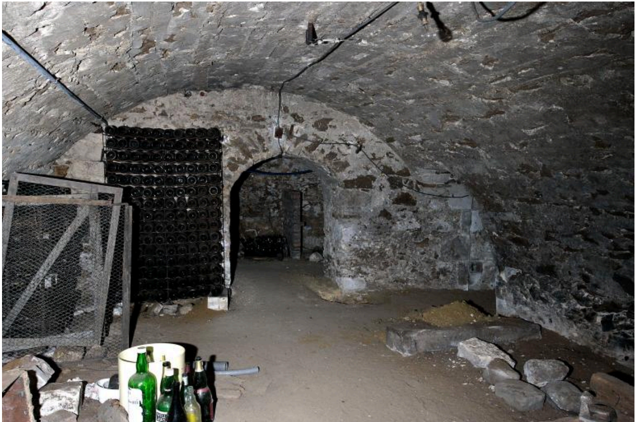
Le pavillon, sous-sol, 2007.
