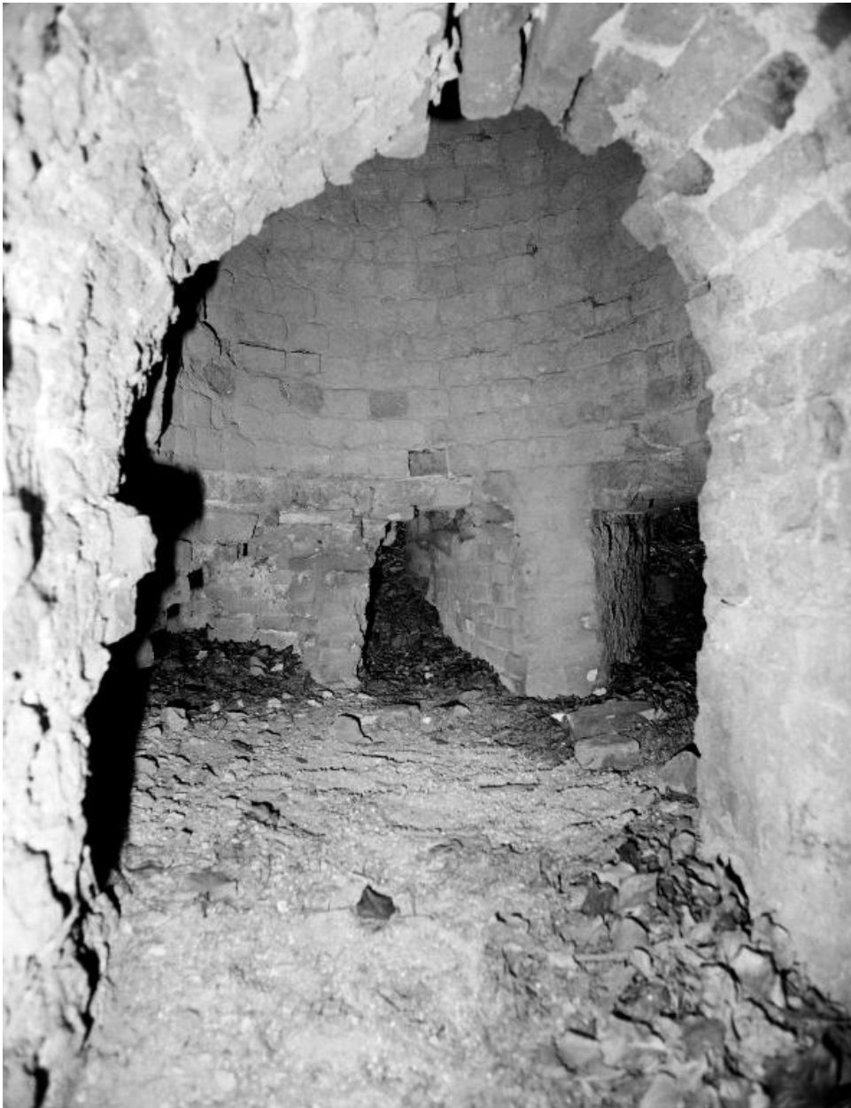
Intérieur du haut-fourneau (1984)
