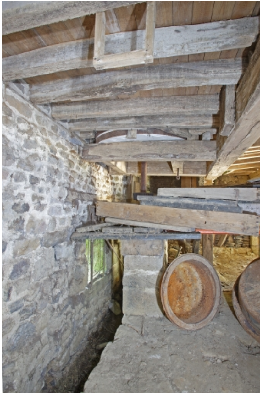
Le moulin à farine sur la Mayenne, rez-de-chaussée : emplacement du rouet de fosse (disparu), pignon de renvoi et meules.
