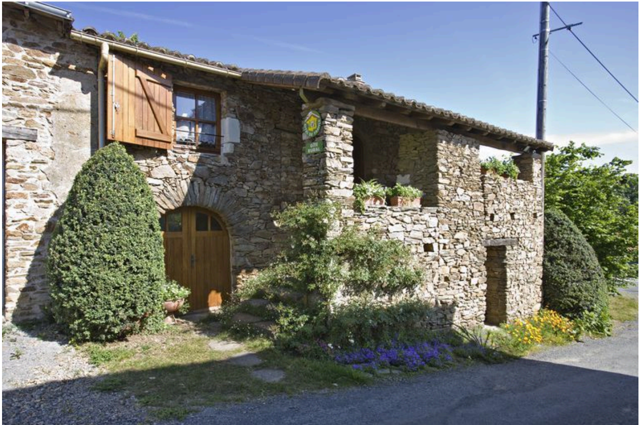
Maison de vigneron, vue du sud-est.
