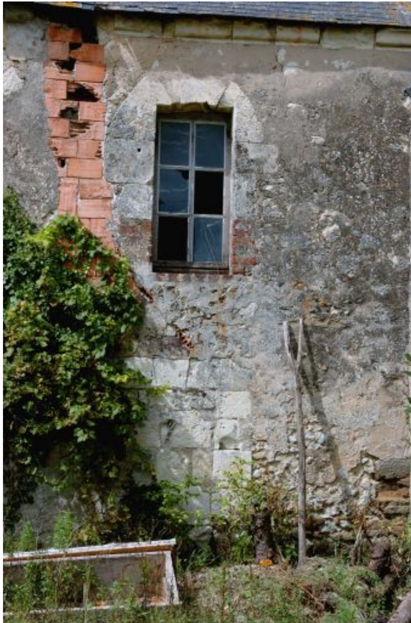
Élévation face à l'entrée, détail.
