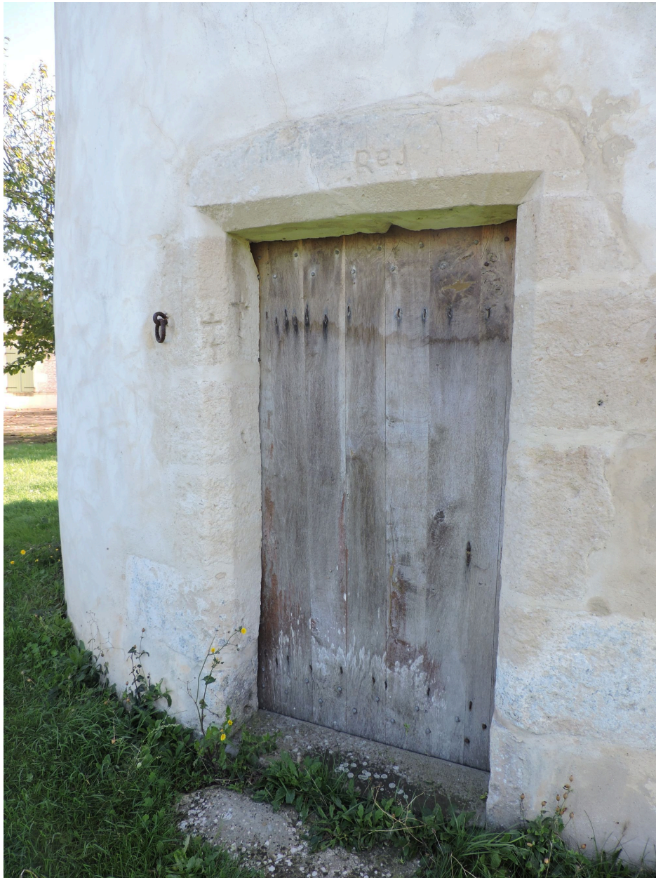
Porte à encadrement chanfreiné au nord-ouest du moulin.
