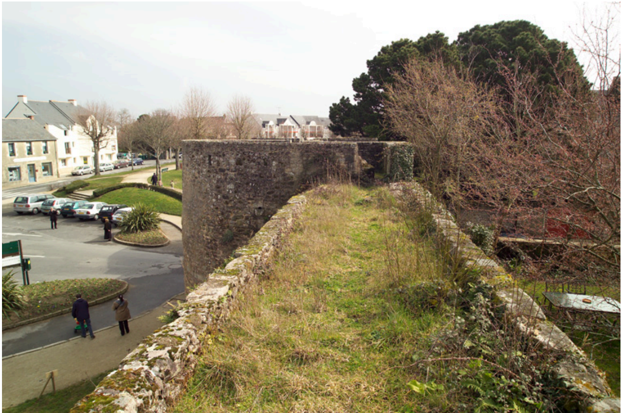
Chemin de ronde voisin de la tour ouest.
