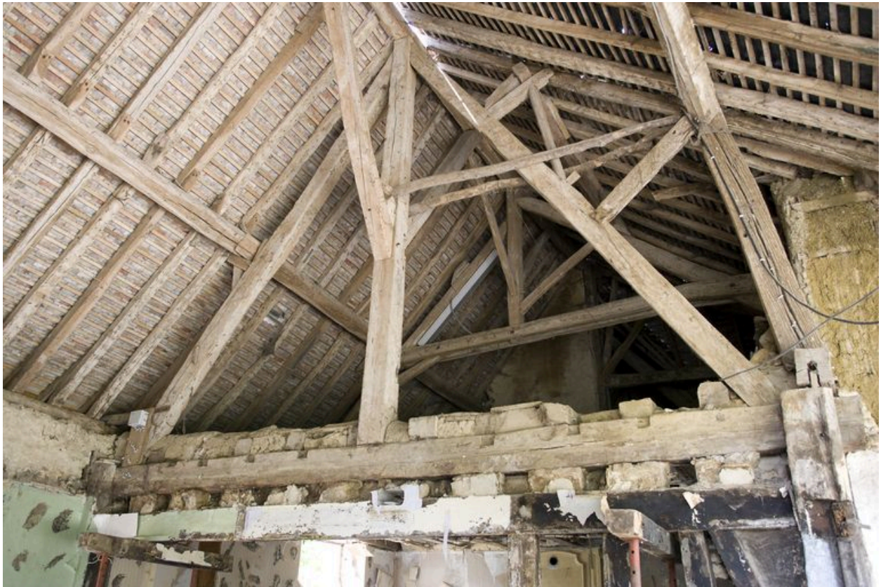
Logis, ferme de charpente au-dessus du mur de refend.
