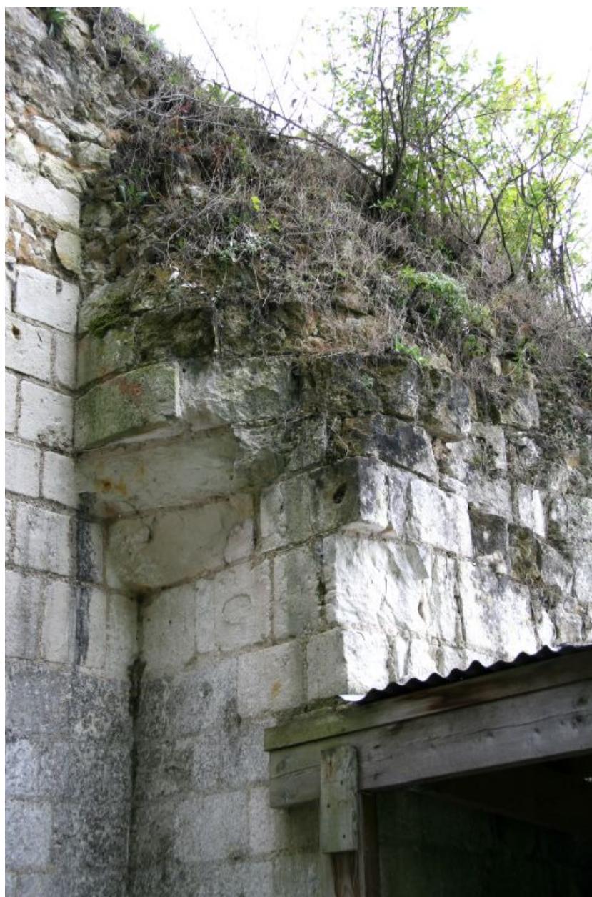
Ancien château, façade postérieure : vestige de l'encorbellement d'une tourelle.
