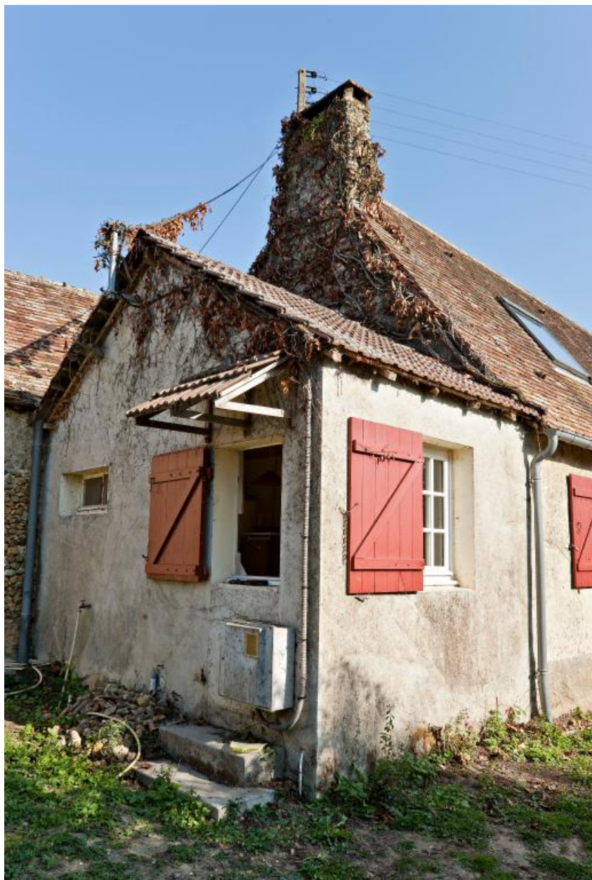
Maison : mur-pignon ouest (masqué par une adjonction).
