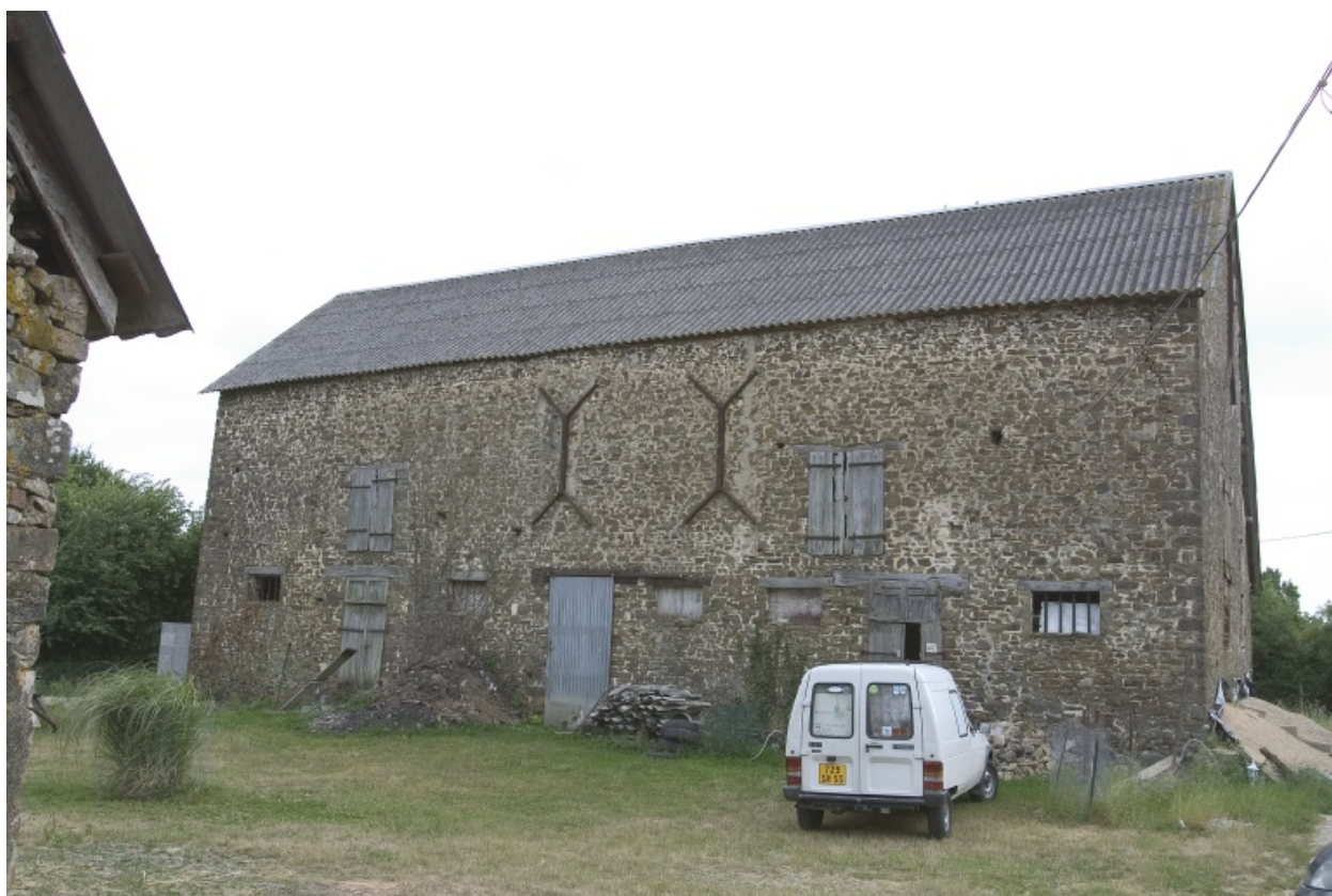
L'étable-grange : façade nord.
