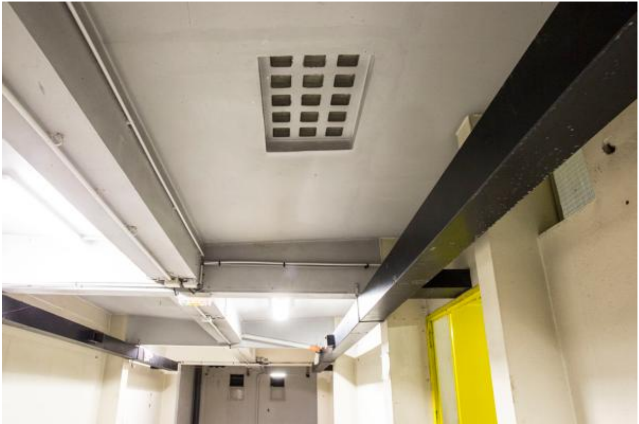
Vue des éléments de chaufferie au premier étage de la piscine.
