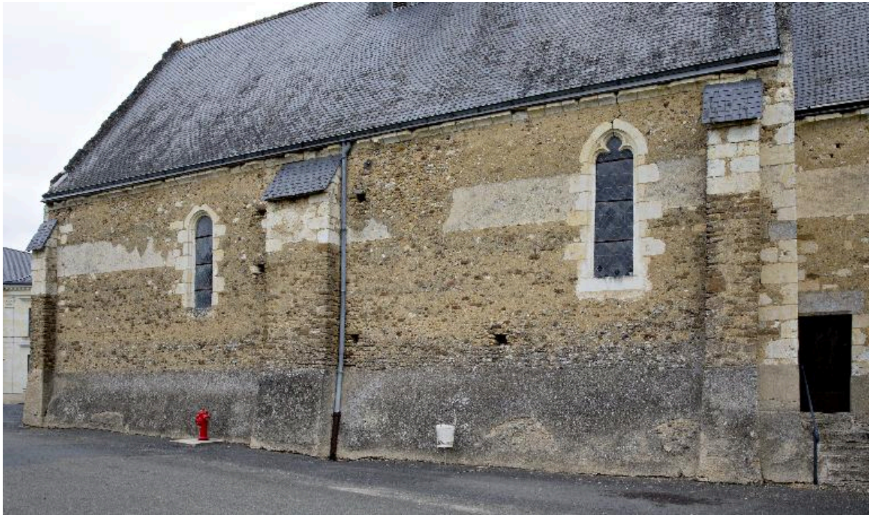
Nef : mur sud.
