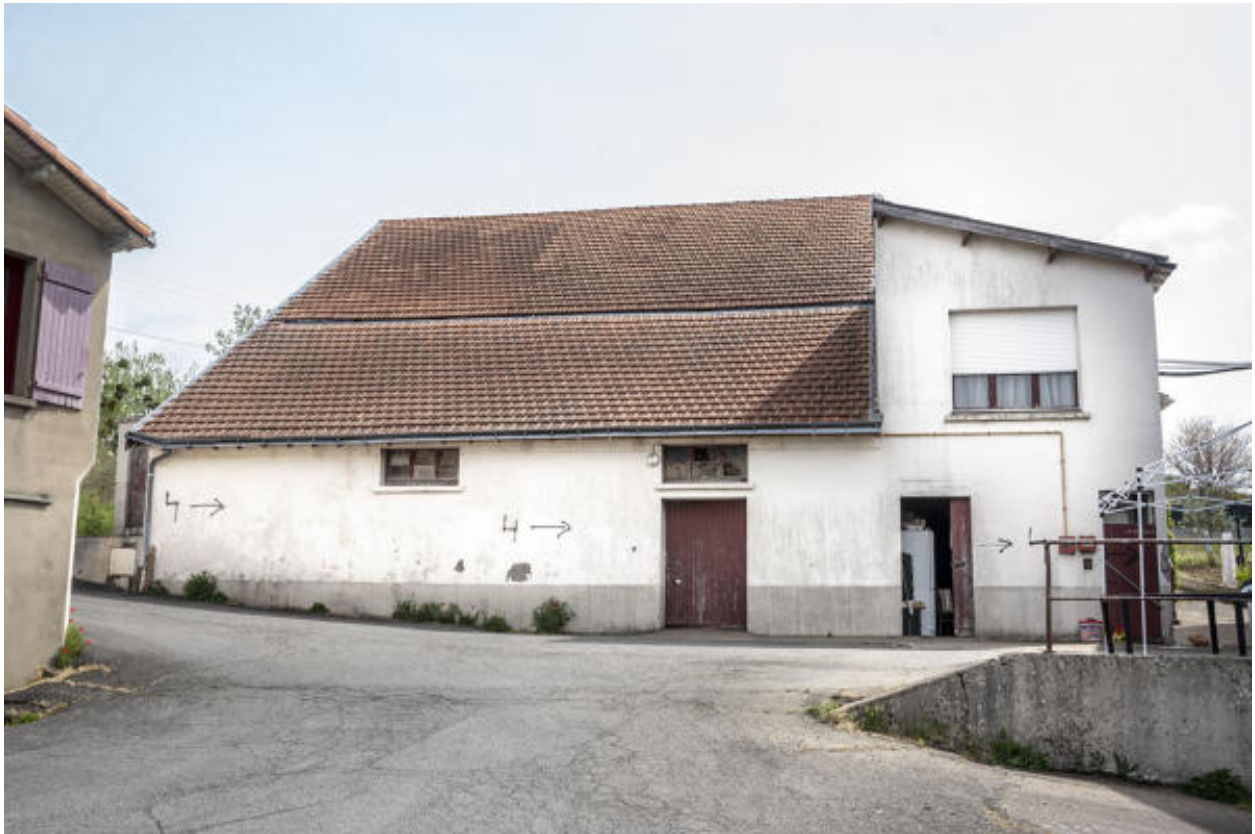
Bâtiment de filtrage et de mise en bouteille, site de la rue des Rosiers.
