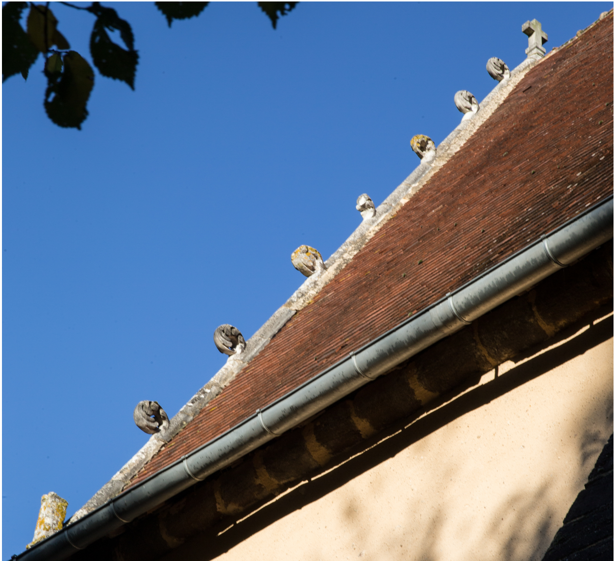
Un détail d'un rampant du pignon de la façade occidentale.
