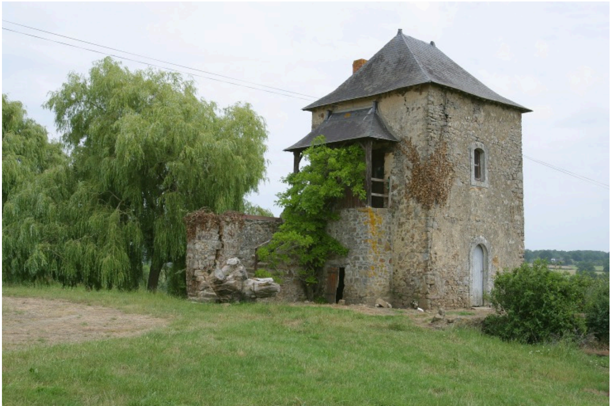
Le bâtiment d'entrée vu depuis le sud-ouest.
