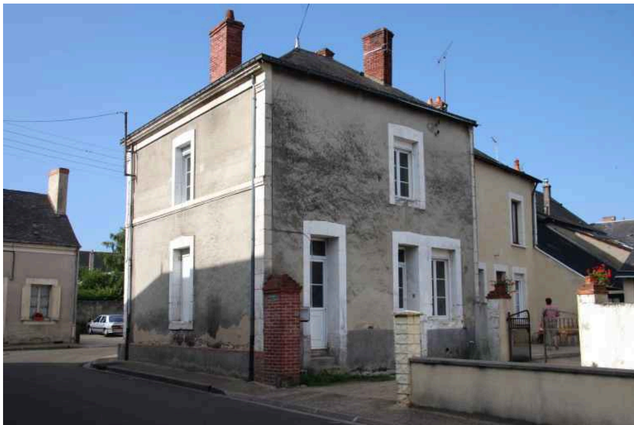
Rue des Mimosas, maison d'angle : façade postérieure.
