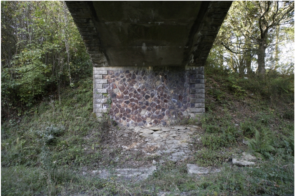
Culée perdue en moellon à tête dressée.
